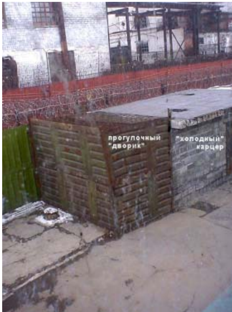
В этом "бетонном мешке" и железной будке с открытым верхом Михаил Трепашкин провел около двух недель при 35-градусном морозе
